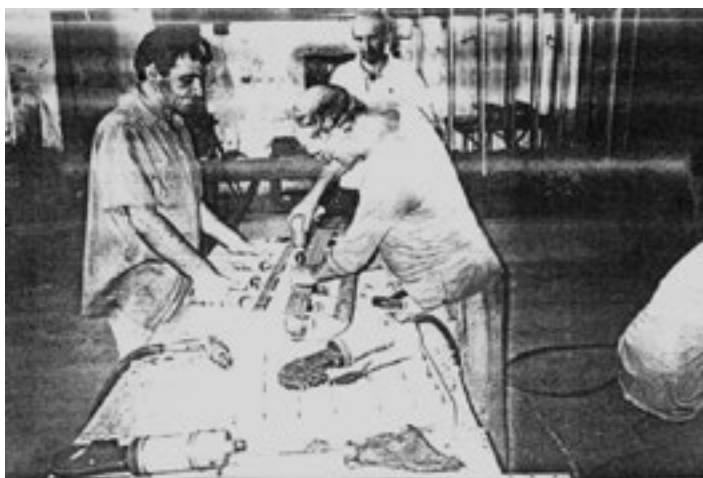
Фиг. 16 Процесс сборки Лопастей ВИГ
